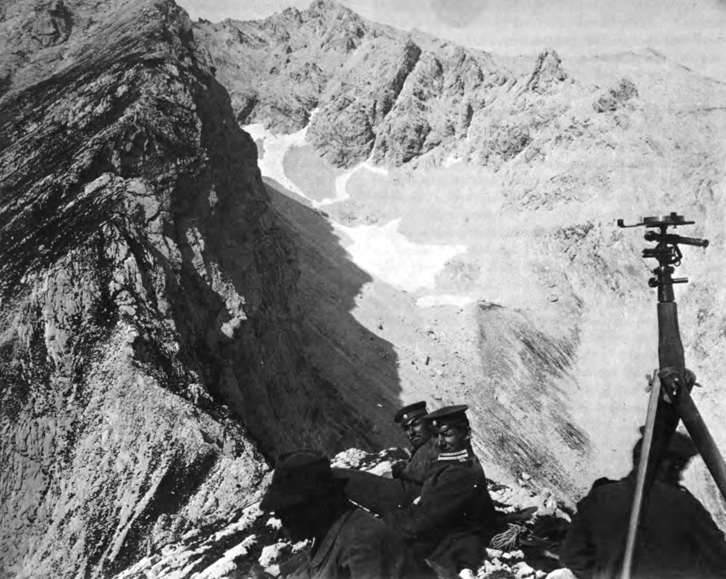
Abb. 063: Gletschervermessung mit einem Phototheodoliten auf dem Brunntalkopf, 1892
