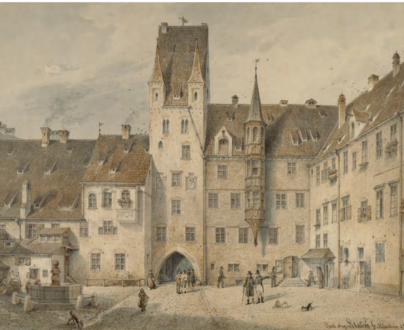
Abb. 144: Der Alte Hof in München Carl August Lebschée, 1869
