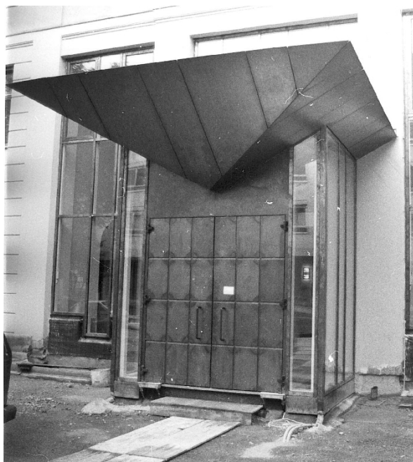
Abb. 172: Neu gestalteter Haupteingang 1990
