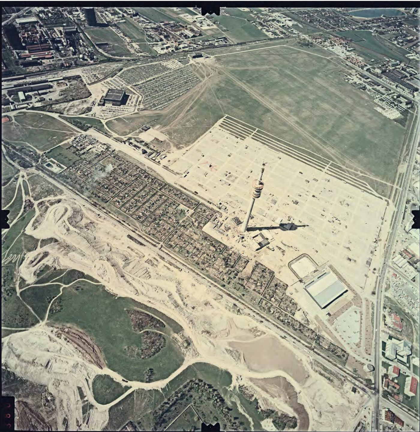
Abb. 139: München, Oberwiesefeld, Bau des Olympiaparks, Farbpositiv, Schrägaufnahme, 1967
